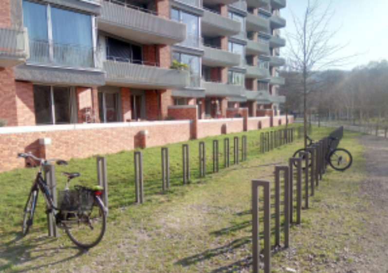
Unversiegelte Veloabstellfläche, Freilager Zürich-Albisrieden
