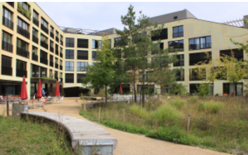
2000-Watt-Areal, Genossenschaft Kalkbreite, Zürich
